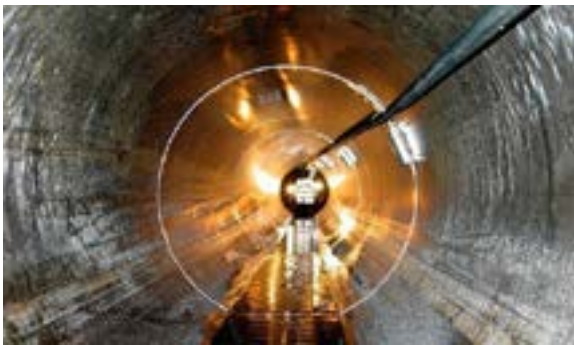
▲ Verlegung eines Glasfaserkabels im Abwasserkanal
