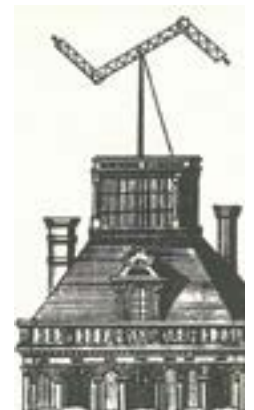
▲ Der optische Telegraf von Claude Chappe auf dem Dach des Pariser Louvre, um 1800.
