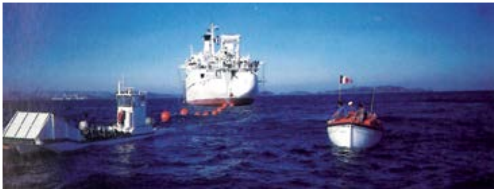
◀ Verlegung von Seekabeln per Schiff
