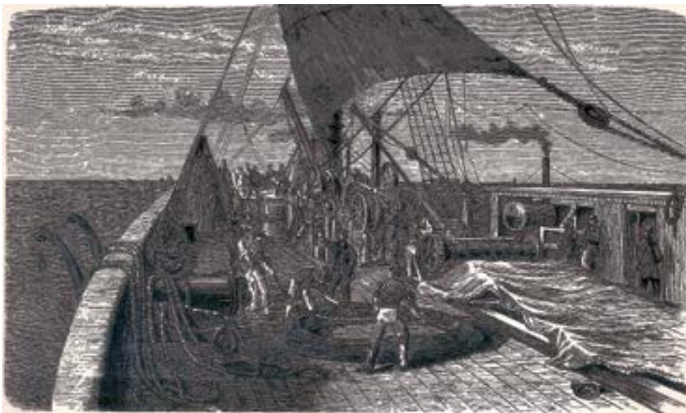
◀ Arbeiten an Bord zur Wiederaufnahme eines verlorenen Kabels
